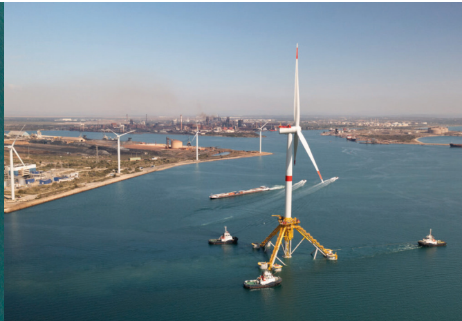
Mise à l'eau des éoliennes de Provence Grand Large - © Iann Hanning
